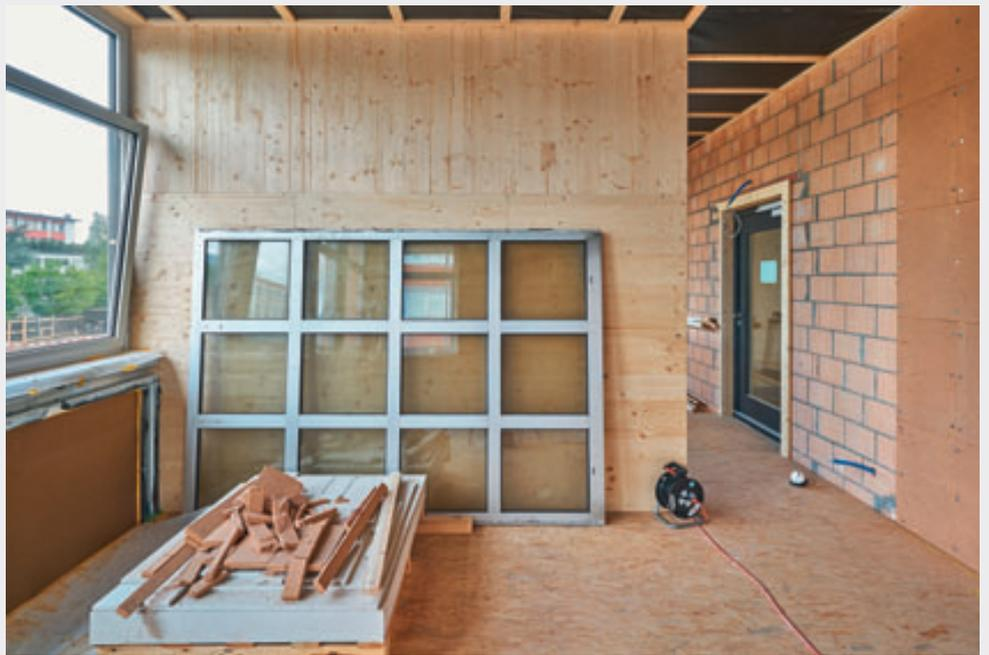
In der Sprint-Unit kommen wiederverwendete Fenster zum Einsatz. Für die Anwendung in der Unit wurde mit vier verschiedenen Nachrüstvarianten experimentiert.
