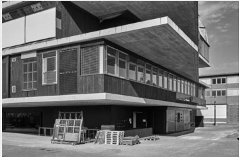
*Für die Fassade der Sprint-Unit wurden die Holzlatten des NEST «Backbone», welche beim Einfügen der neuen Unit abmontiert wurden, wiederverwendet. Die PV-Module stammen aus vergangenen Projekten.*
