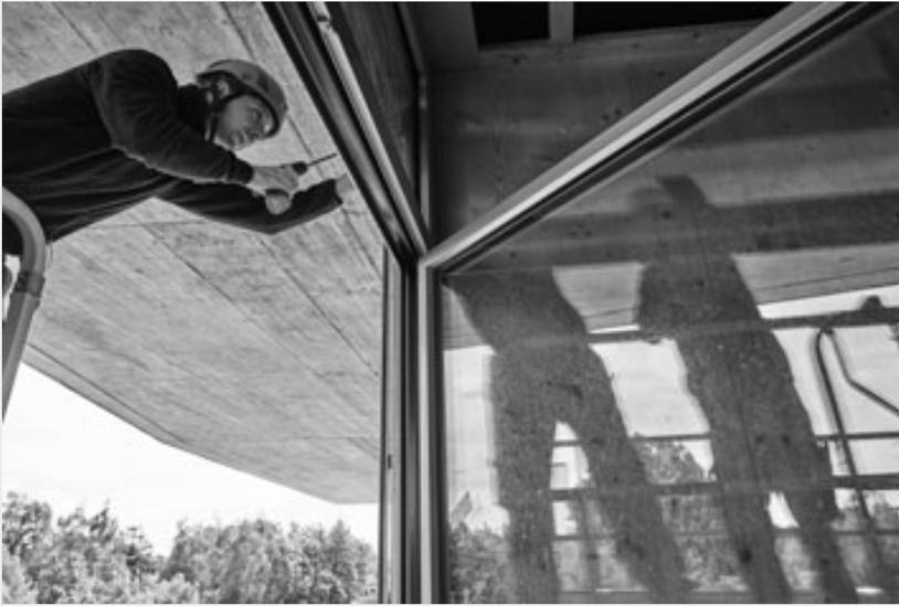
*Damit die Materialien beim Rückbau wieder sortenrein getrennt werden können, kamen beim Bau der Sprint-Unit grösstenteils Verschraubungen zum Einsatz.*
