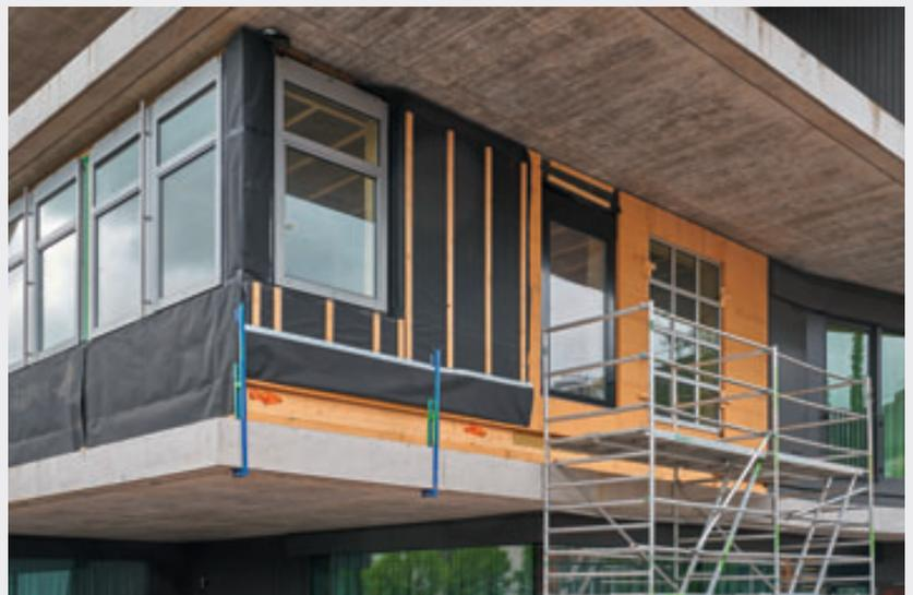
Im Sprint-Projekt wurden Boxen in die Fassade integriert, die den Fensterbereich vorgeben. Durch diese rückt die Grösse und das Aussehen der Fenster in den Hintergrund, wodurch die Flexibilität beim Einbau von wiederverwendeten Fenstern enorm erhöht werden konnte.
