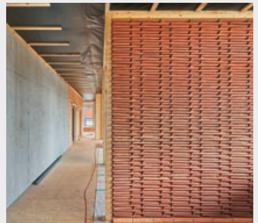
Eine der Bürotrennwände in der Sprint-Unit besteht aus Ziegeln, die eigentlich als Ausschuss auf der Deponie gelandet wären. Damit diese beim Rückbau wieder sortenrein getrennt werden können, wurden sie mittels Lehm vermauert.
