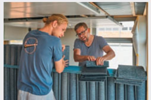
Die eigens für die Unit-Sprint konzipierte, innovative Teppichwand besteht gänzlich aus wiederverwendeten Teppichfliesen und kann nach Verwendung vollständig rückgebaut werden. Die Teppichwand wurde im Akustiklabor der Empa auf ihre Luftschalldämmung geprüft und tritt nun in der Unit den Praxistest an.
